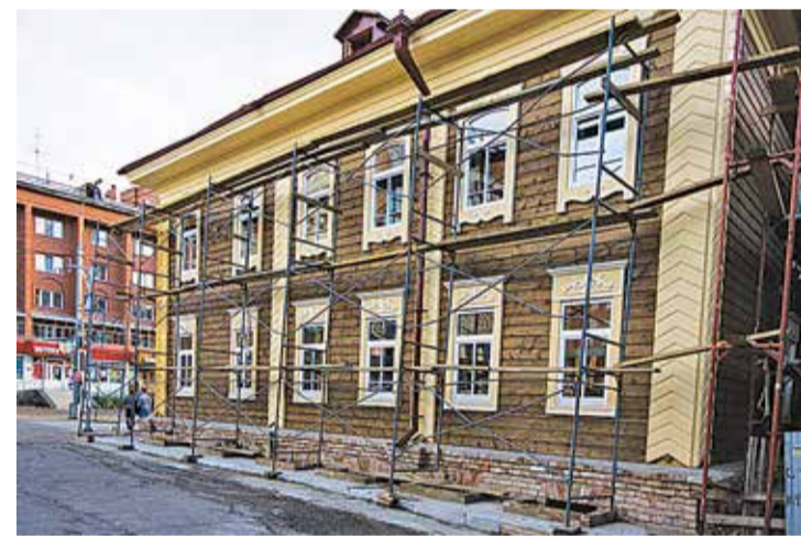
При реставрации дома по пр. Фрунзе, 32а, удалось сохранить значительную часть подлинных бревен
